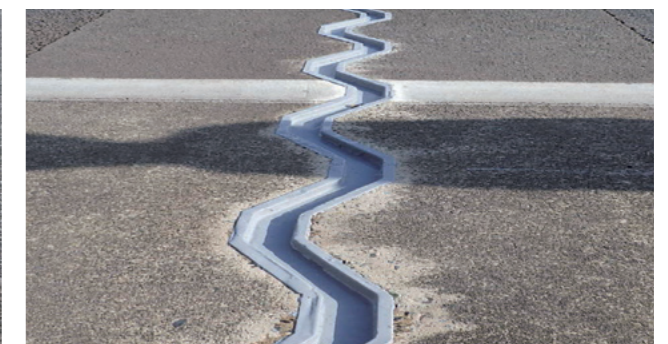
[九州道 大野高架橋] (施工:令和3年1月)
