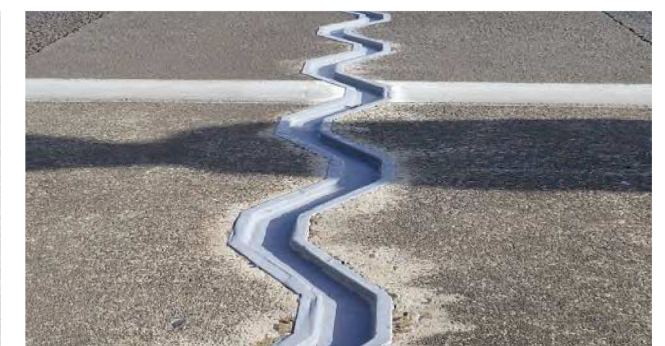
[九州道 大野高架橋] (施工: 令和3年1月)
