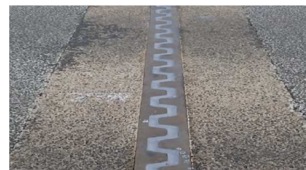
[九州道 白川橋] (施工: 令和元年9月)
